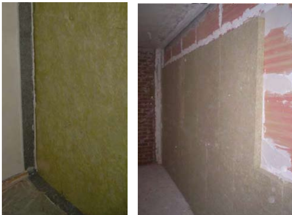
Colocación de bandas elásticas y lana mineral en los elementos separadores.
