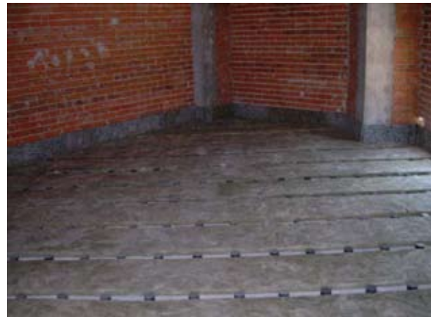
Ejecución de bancadas flotantes en salas de instalaciones.
