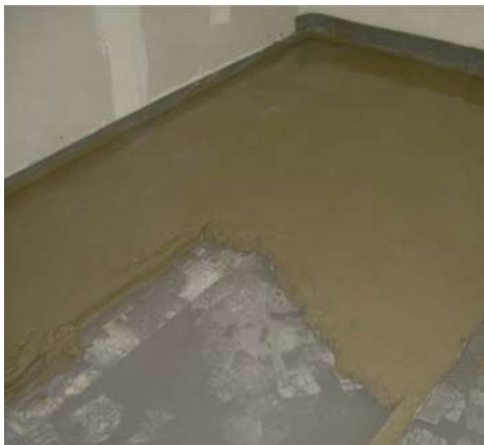
Colocación de láminas anti-impacto y mortero autonivelante.
