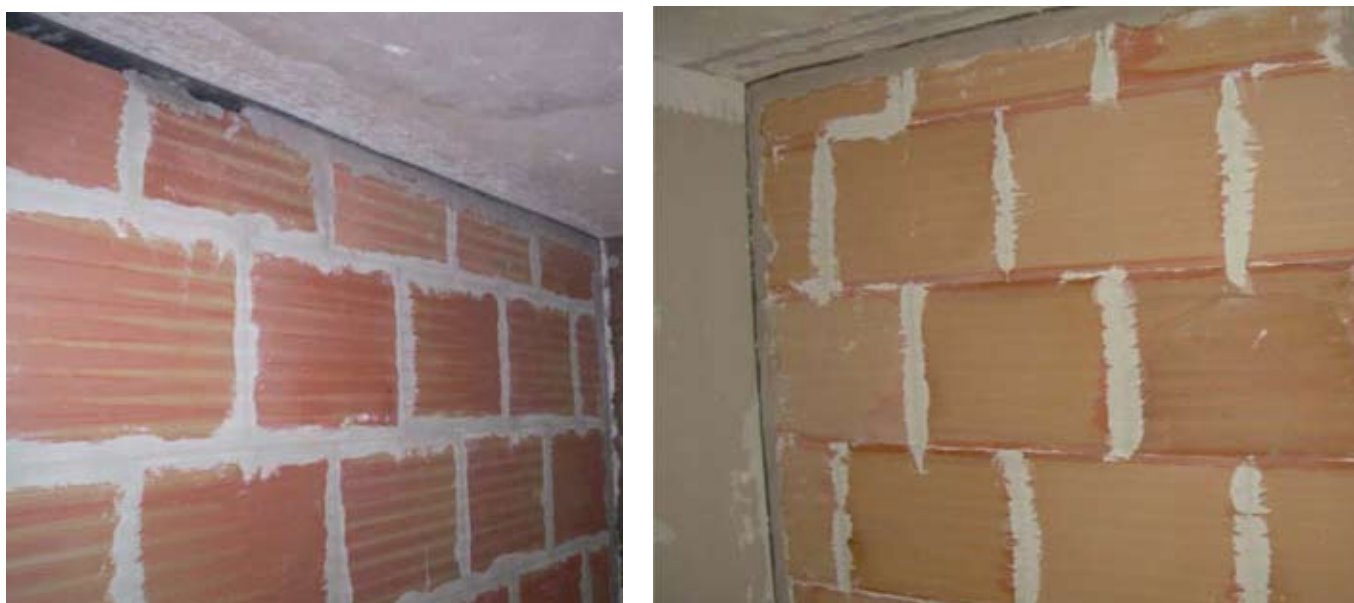
Ejecución de las fábricas de ladrillo hueco doble gran formato de los elementos separadores.
