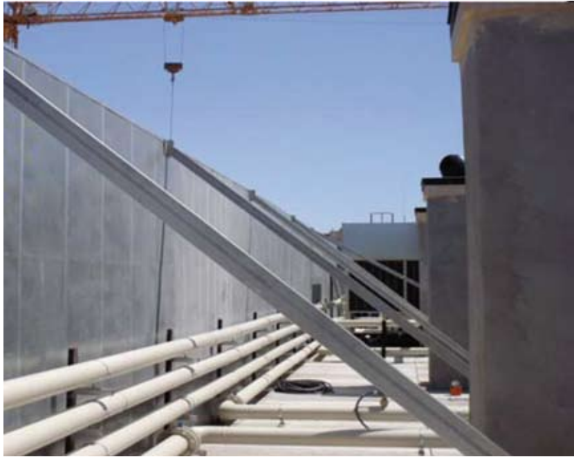
Instalación de pantallas acústicas para maquinaria de cubierta.
