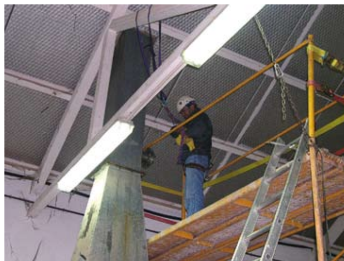
Fotografía 3: Mediciones en la chimenea del horno para la validación medioambiental
